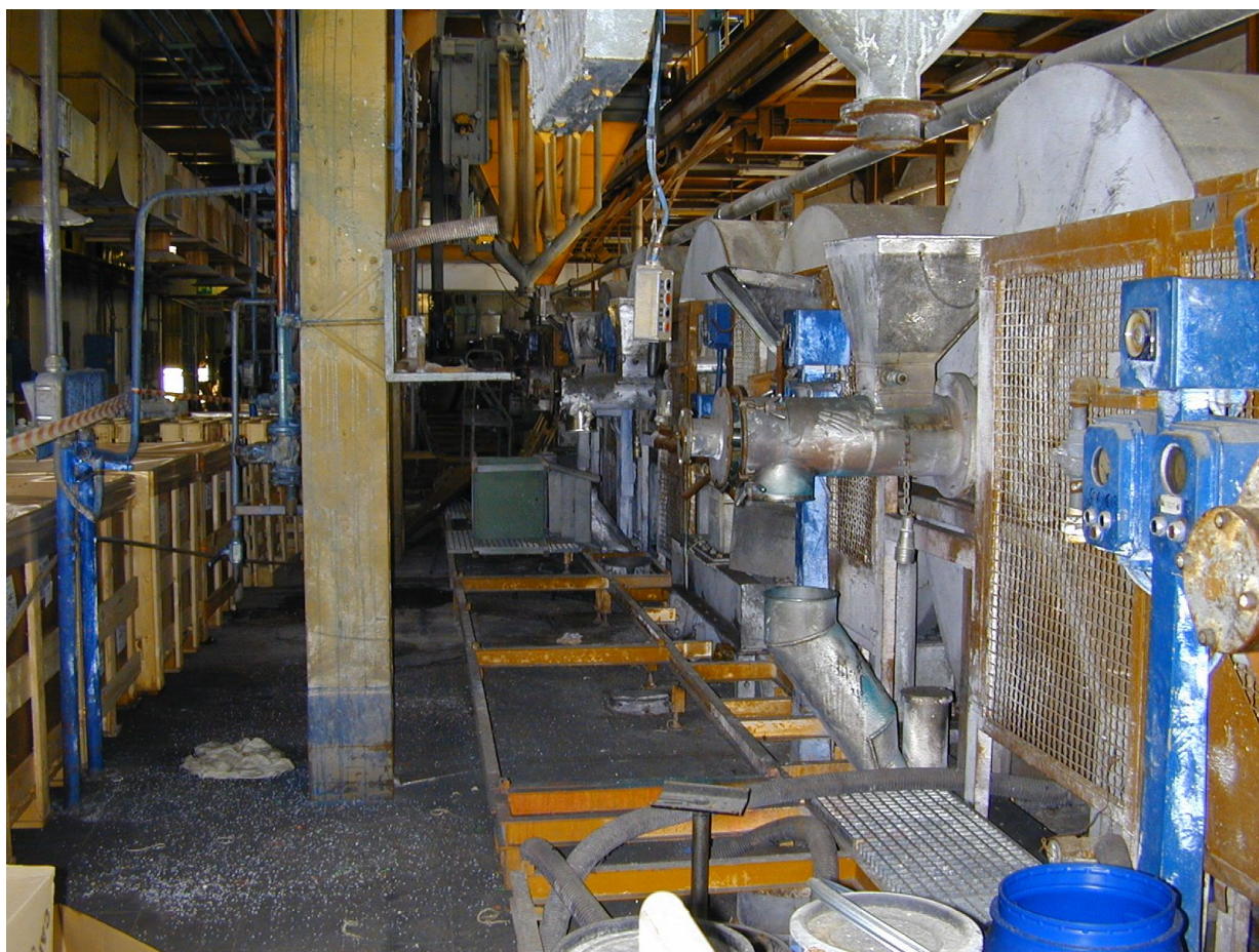
Figura D.2 – Ripresa fotografica effettuata il 16.aprile 2003 all'interno del Reparto ST9 (“Sala vecchia”) Zona carico - scarico Blender
