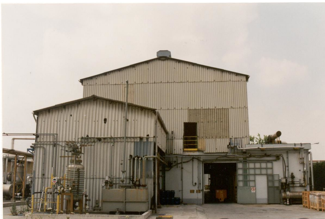
Figura B.11 – Ripresa fotografica di capannone industriale del Petrolchimico di Mantova
